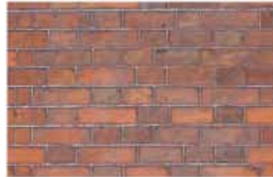
Tuck pointing (Berkhamsted)
