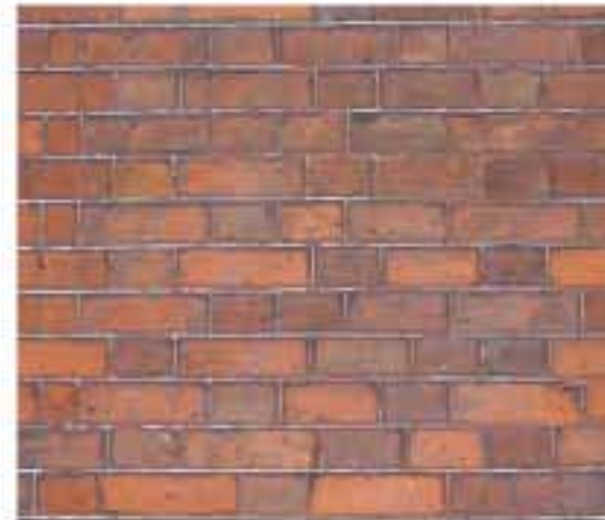
Tuck pointing (Berkhamsted)
