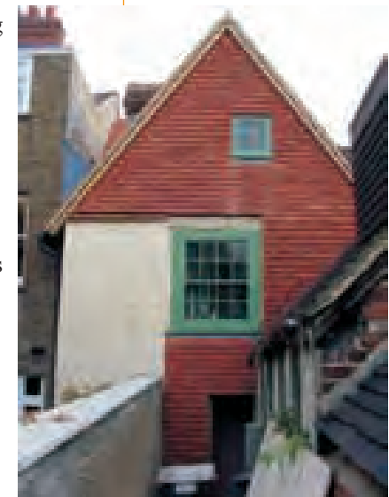
Tile-clad walls (Berkhamsted)
