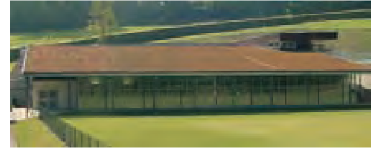
Green roof (Berkhamsted)
